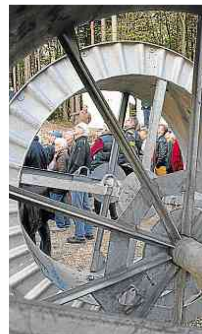
Auf riesigen Spindeln wird die Litze geliefert, mit der die Betonringe der Türme innen verspannt werden.
