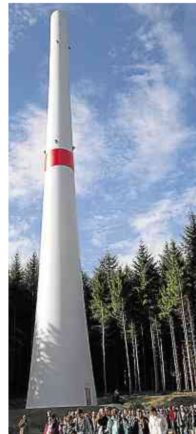
Winzig nehmen sich die Besucher unter dem halb fertigen Mast aus.
