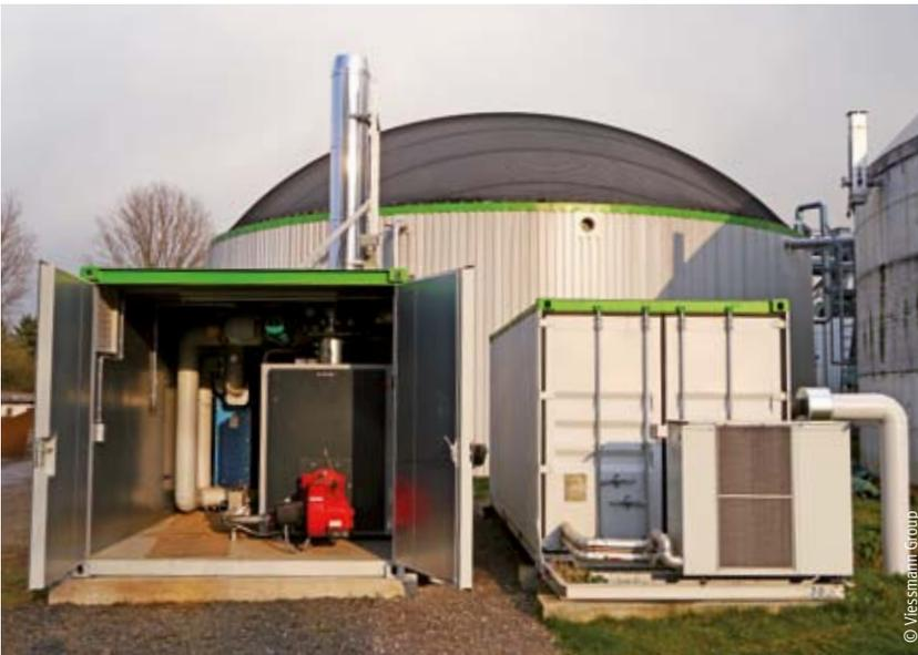
Abb. 5-7: Verdichterstation zum Transport des Biogases zum Satelliten-BHKW und Biogaskessel als „Facklersatz“ an der Biogasanlage im Bioenergie-dorf Wettesingen
