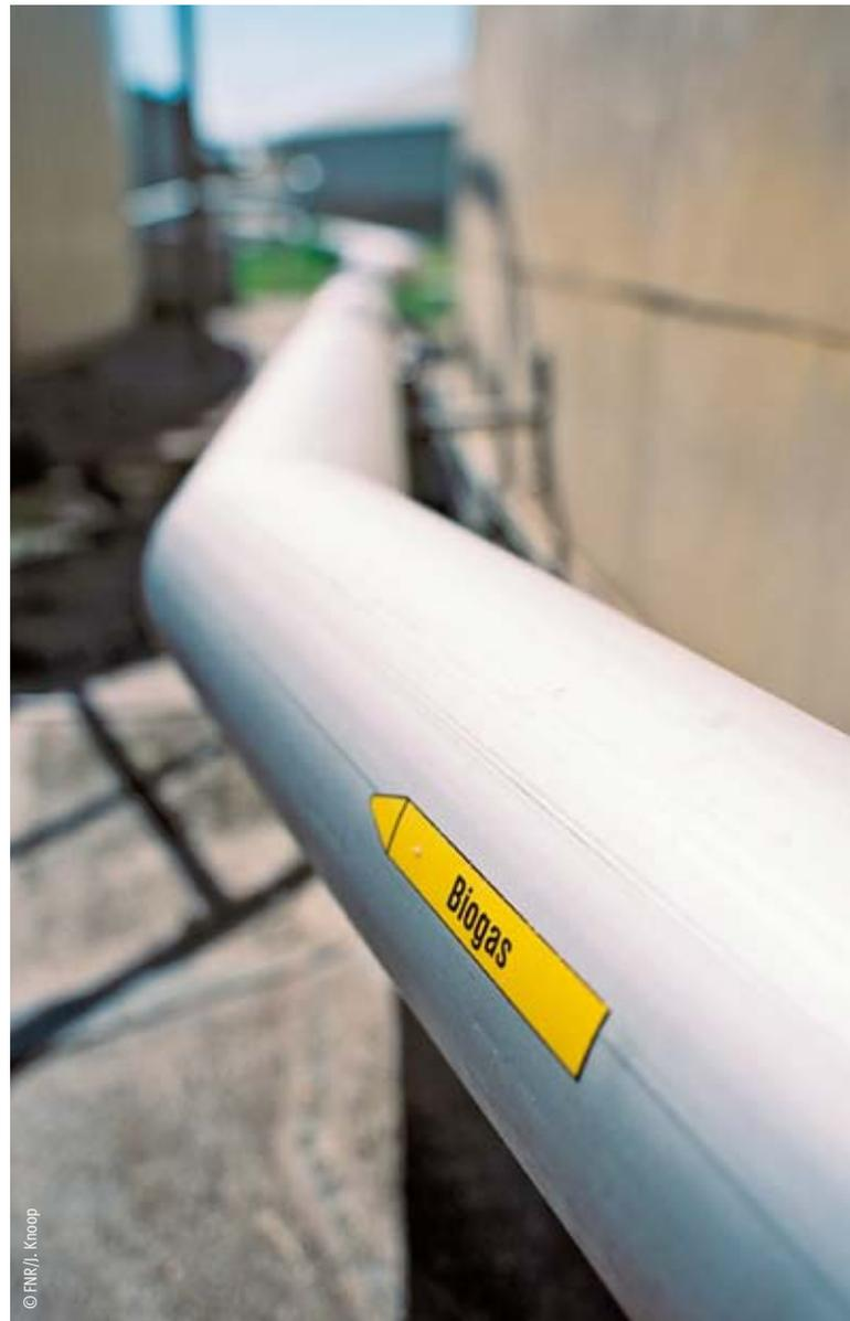
Abb. 5-4: Biogasleitung zur Heizzentrale
