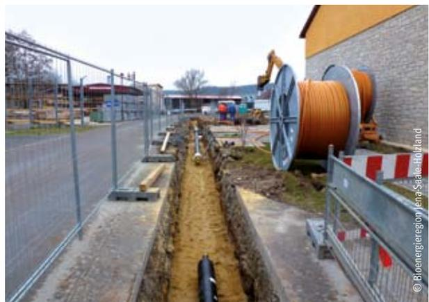
Abb. 3-7: Verlegung von Glasfaser- und Nahwärmeleitungen im Bioenergiedorf Schlöben
