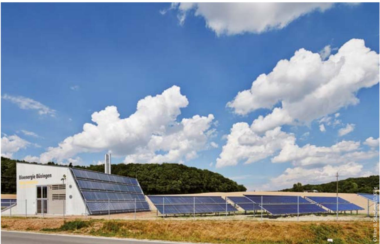
Abb. 4-12: Einsparung von Biomasse-Rohstoffen durch die Nutzung solarer Wärme im Bioenergiedorf Büsingen
