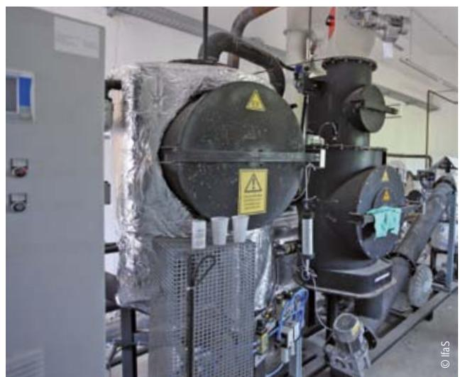
Abb. 5-9: Holzpellet-Vergaser in Schönbrunn (links), Hackschnitzel-Vergaser im Bioenergiedorf Heubach (rechts)
