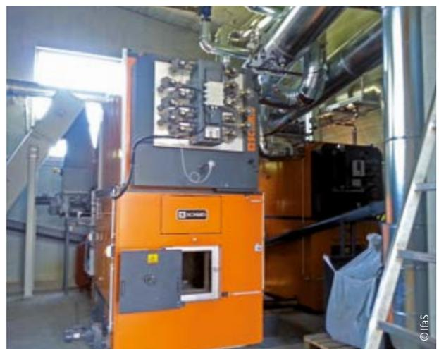
Abb. 5-8: 700 kW-Hackschnitzelheizkessel im Bioenergiedorf Leiberdingen (oben), zwei 900 kW-Hackschnitzelkessel im Bioenergiedorf Büsingen (unten)
