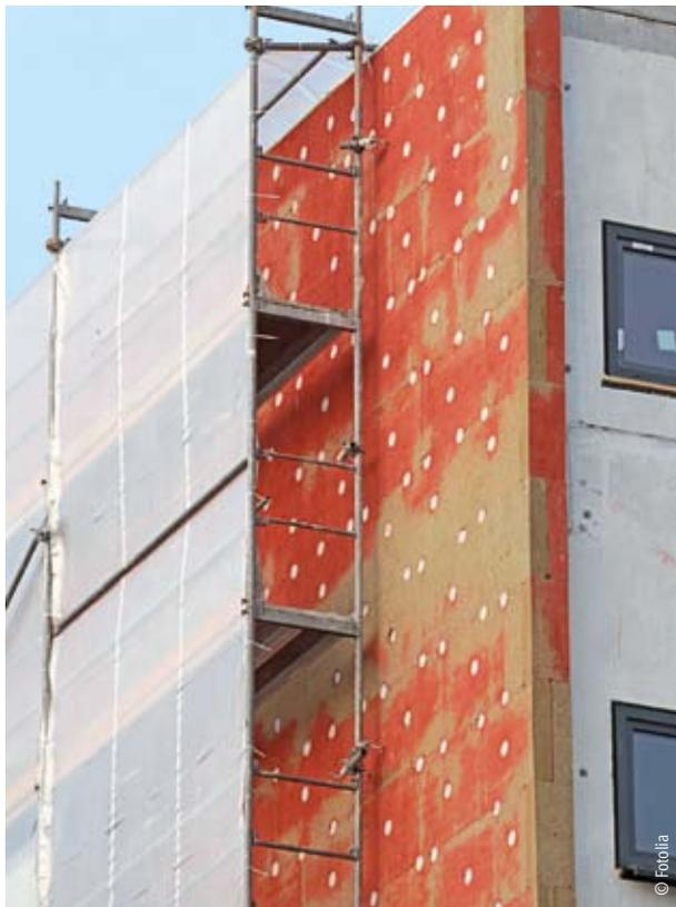
Abb. 6-16: Dämmung der Außenwand
