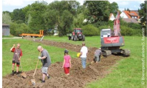
Abb. 3-12: Verlegung von Gas- und Nahwärmeleitungen durch Bürger im Bioenergiedorf Larrieden/S. Bayern
